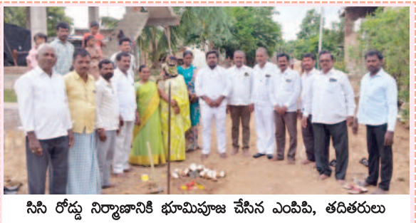
సిసి రోడ్డు నిర్మాణానికి భూమిపూజ చేసిన ఎంపీపి, తదితరులు
